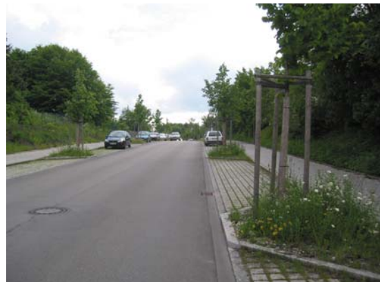
Beispiel einer innerörtlichen Straße
